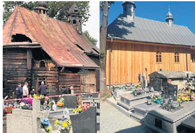
Odbudowany kościółek póki co można podziwiać tylko z zewnątrz. Na cmentarzu wciąż prowadzone są prace
