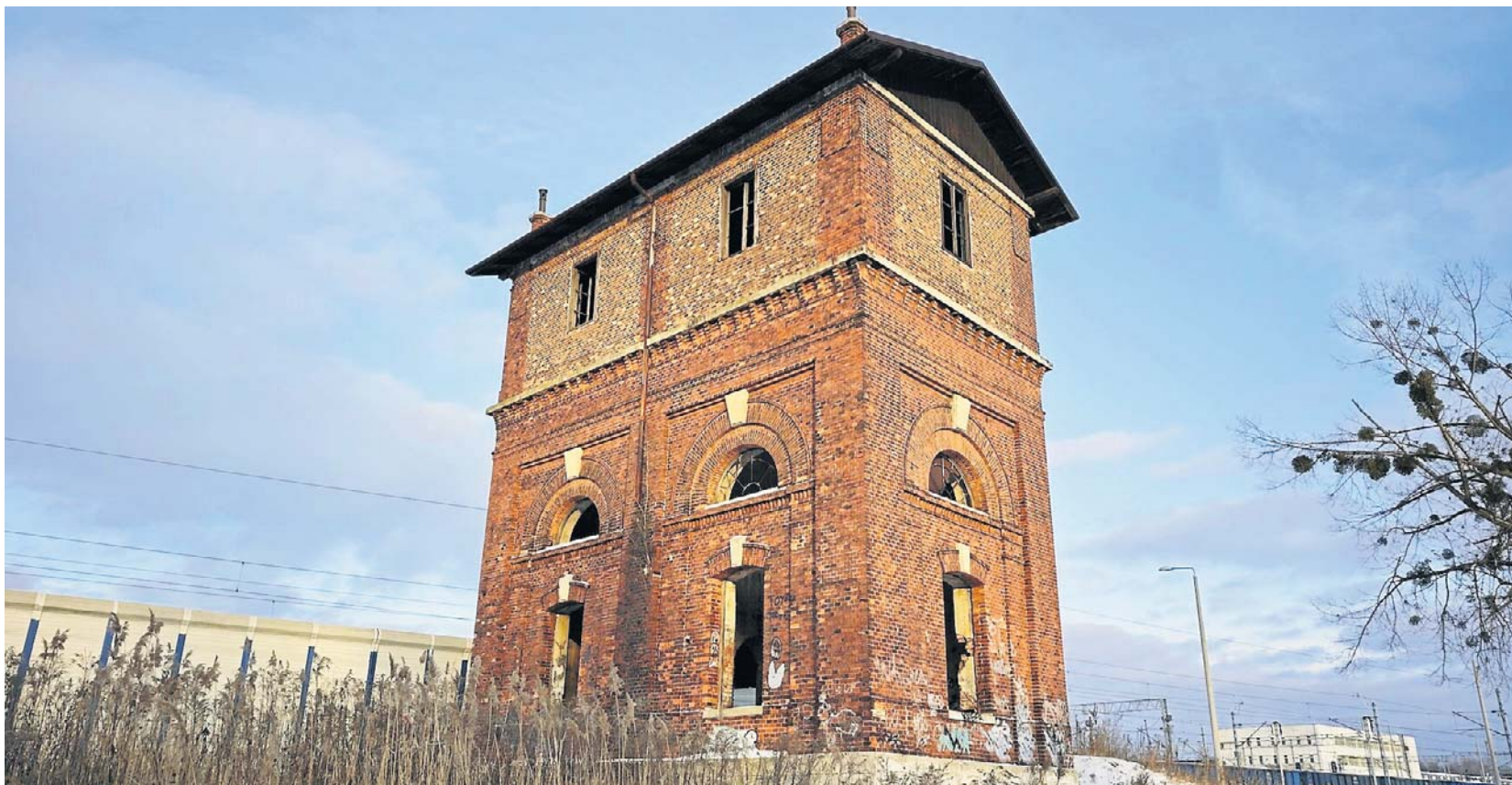
Wieża ciśnień w Trzebini jest jednym z pięknych przykładów kolejowego dziedzictwa powiatu chrzanowskiego. Niedługo może zniknąć
