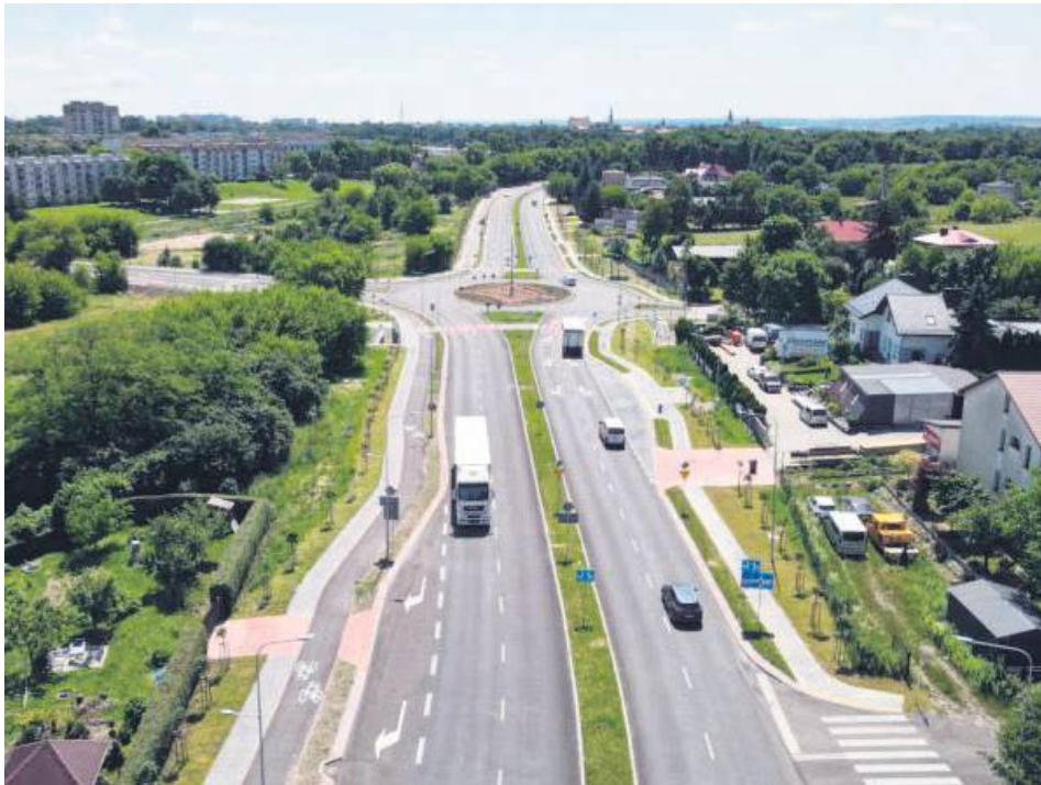
Ponad 5-kilometrowy odcinek drogi krajowej nr 74 został oddany do użytku po wartej blisko 100 mln zł przebudowie w zeszłym roku.
