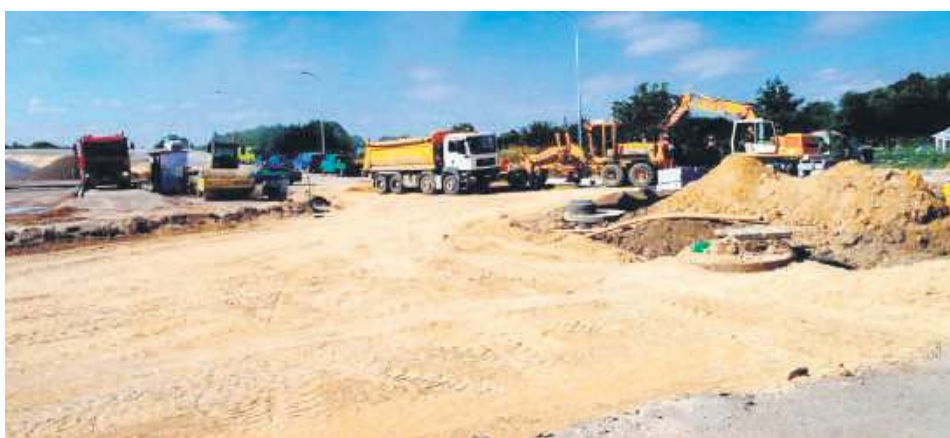
Prawdopodobnie w przyszłym roku rozpoczną się prace przy budowie północnej obwodnicy Hrubieszowa.
