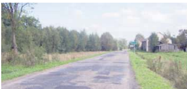
Łączna wartość umów to ponad 2,4 mln zł. Za te pieniądze gminy wybudują prawie 2 km oraz zmodernizują ok. 14 km dróg.
