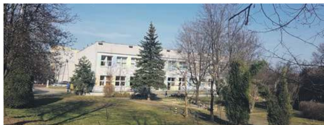
Działka z budynkiem po przedszkolu przy Wańkowicza w Libiążu
