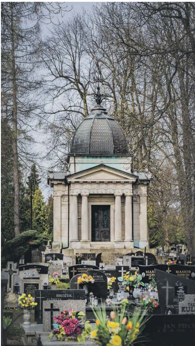
Mauzoleum jest najbardziej charakterystyczną budowlą na chrzanowskim cmentarzu
