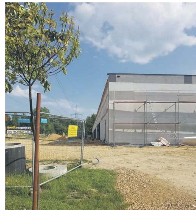
Problematiczny jest wyjazd z budowanego pawilonu przy ul. Chrzanowskiej
