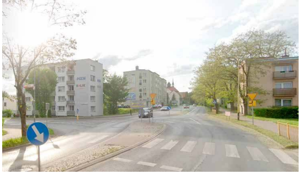
Zgodnie z zapisami w budżecie gmina dołożyć ma 4 mln zł na budowę ronda, czyli inwestycję ZZDW
