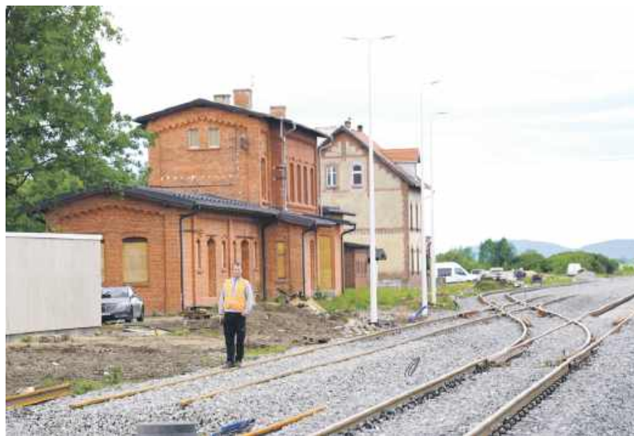
Gotowa linia zostanie oficjalnie oddana do użytku na początku września
