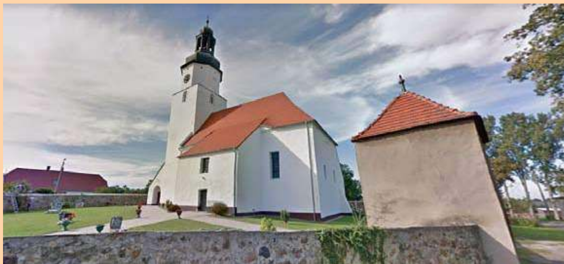
20 tys. zł pójdzie na, jak czytamy we wniosku, „prace konserwatorskie i restauratorskie emporii muzycznej w kościele św. Anny” w Broniszowie (fot. Google Maps)
