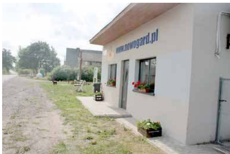
Wyremontowana świetlica w centrum wsi, wyróżnia się na tle całej miejscowości, ale stoi pusta.
