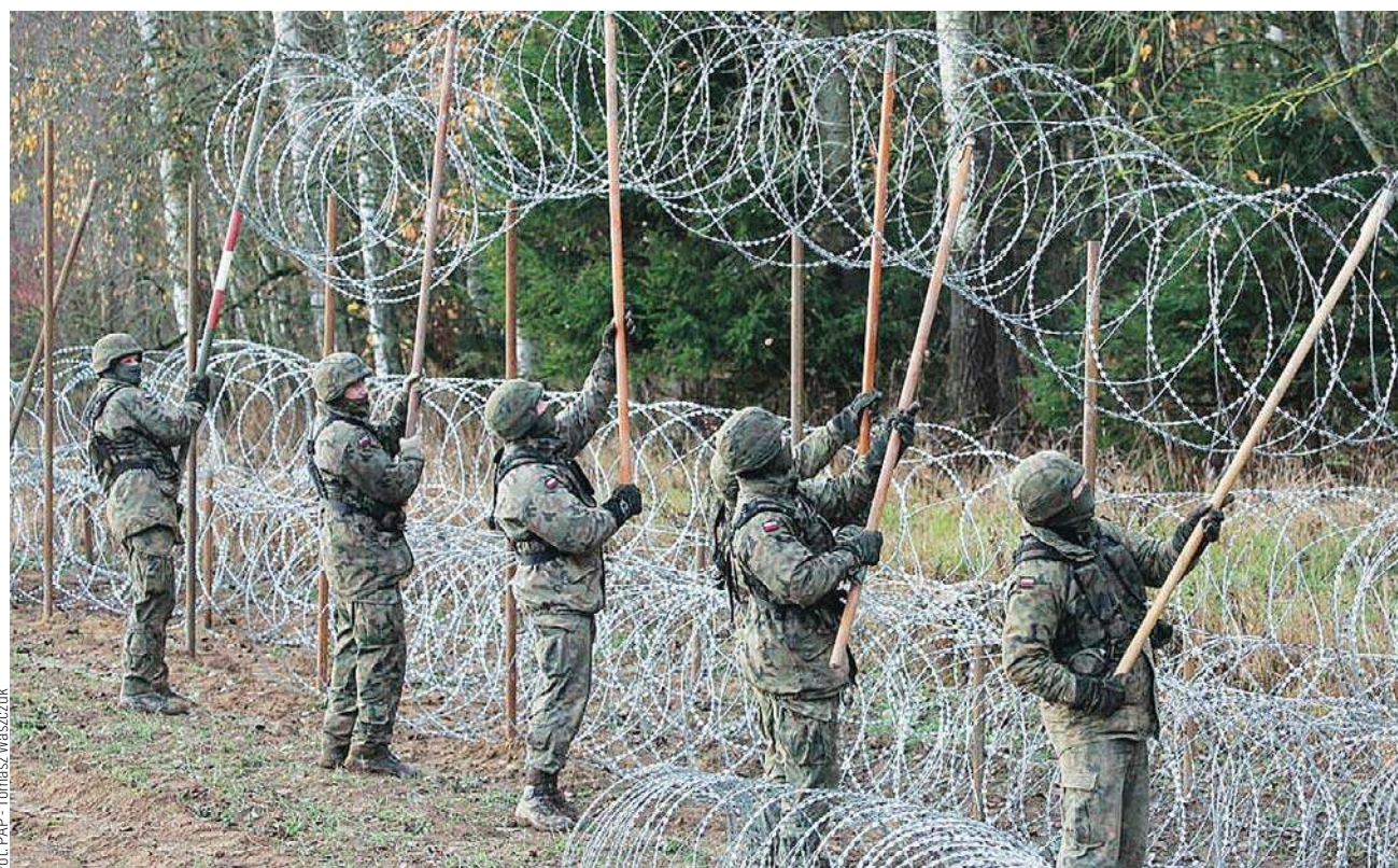
Budowa zapory na granicy z obwodem kaliningradzkim
