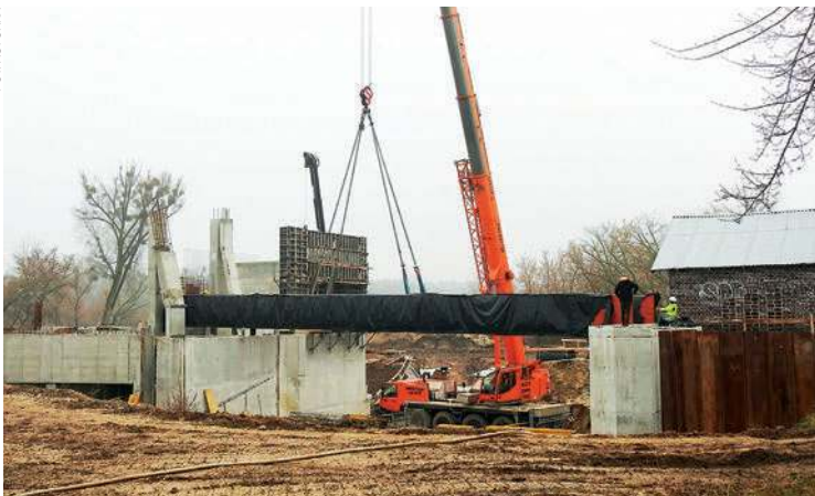
Posadowienie kładki na podpory główne odbyło się przy pomocy 70 tonowego dźwigu
