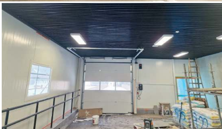
■ Postęp prac w budowie Szpitalnego Oddziału Ratunkowego przy Gamowskiej
