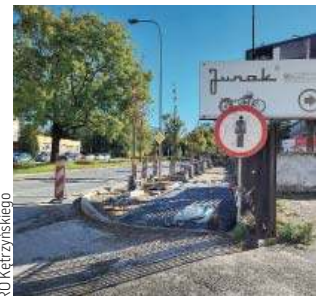
Przebudowa chodnika wzdłuż ul. Kętrzyńskiego
