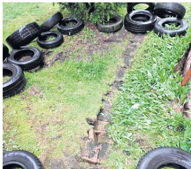
Dziura powstała tuż przy ścianie domu. Inspektor nadzoru budowlanego nie stwierdził uszkodzenia budynku
