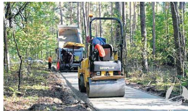
Obecnie prowadzone są prace związane z układaniem kolejnych warstw podłoża
