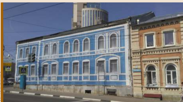
Sprytna rosyjska maskirowka w Niżnym Nowogrodzie. Na starym budynku rozciągnięta niebieska płachta.
