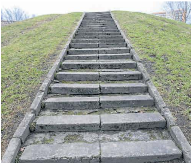
W najbliższym otoczeniu wzniesienia w ostatnich latach dokonywano prac remontowych
