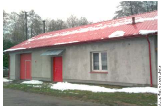
Zakończyła się modernizacja świetlicy w Kolechowicach Kolonii. W ramach tejże inwestycji wymieniono dach, zmodernizowano strop z ociepleniem i utwardzono teren wokół budynku.
