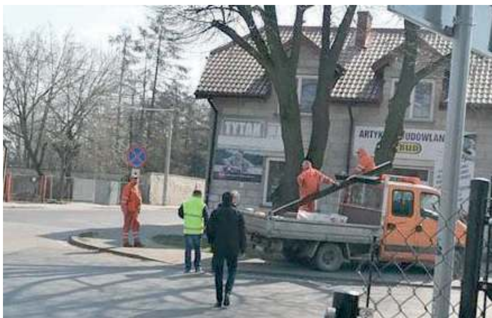
Krzyż mógłby tam być, jest tam miejsce dla niego. Ale powinno się to odbyć inaczej, powinno się zapytać mieszkańców jak powinien wyglądać, z czego powinien być wykonany - uważa Elżbieta Wąs. Na zdjęciu pracownicy Zarządu Dróg Powiatowych w Lubartowie montują nowy krzyż
