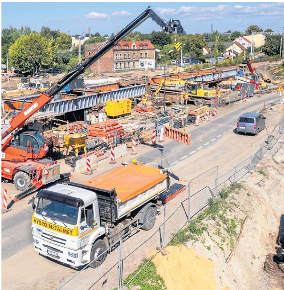
W gliwickich Łabędach trwa jedna z największych inwestycji ostatnich lat - miasto gruntownie przebudowuje układ drogowy, a w sąsiedztwie remontuje i buduje też PLK SA
