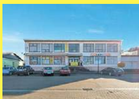
Dom handlowy w samym centrum Janowa Podlaskiego, 885 851 161
