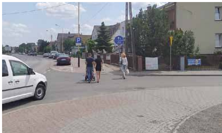
Skrzyżowanie wcale nie jest oznakowane znakami poziomymi
