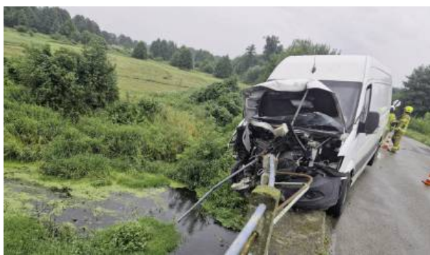
W Kisielanach bus wjechał w bariery mostu na Liwcu.
