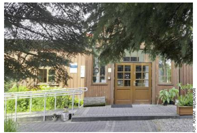
Szacowany koszt przebudowy budynku Środowiskowego Domu Samopomocy w Miedźnie wynosi 500 tys. zł.
