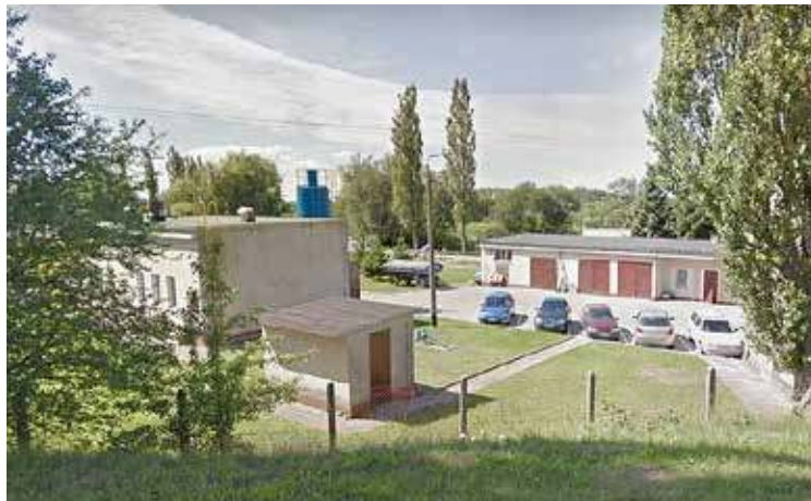
Oczyszczalnia ścieków przy ul. Zamkowej
