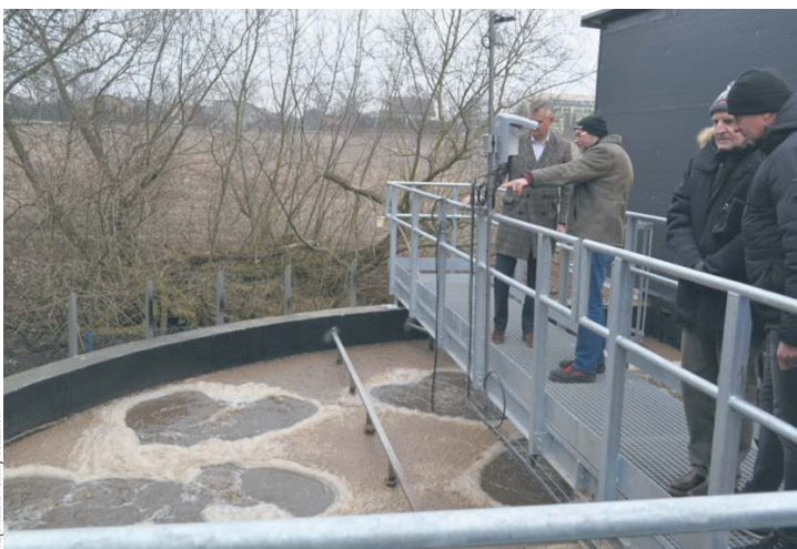
Kwotę ponad 6 mln złotych przeznaczył samorząd Miasta i Gminy Bodzanów na jedną z największych zrealizowanych w ostatnim czasie inwestycji – rozbudowę oczyszczalni ścieków w Nowym Miszewie
