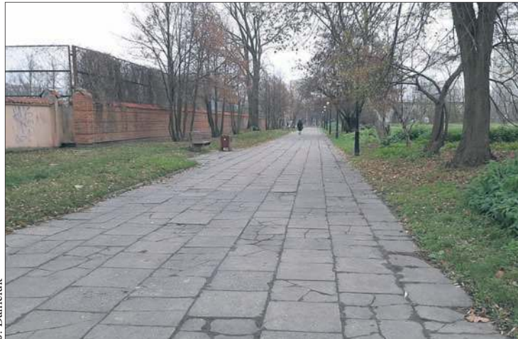
Al. Spacerową czeka gruntowna przebudowa
