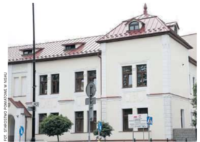
Zrewitalizowany budynek po byłym Areszcie Śledczym stoi przy głównej ulicy Niska. Teraz swym wyglądem pięknie wpisuje się w stylowy charakter centrum miasta
