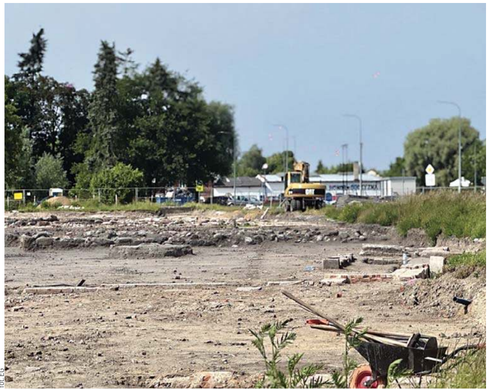
Ulica Warszawska. Teren przyszłego parkingu
