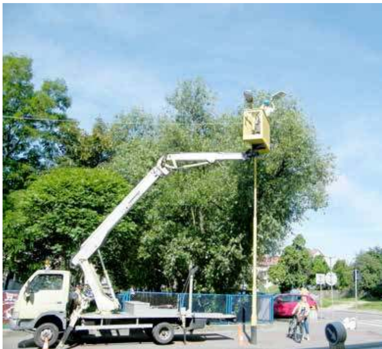
Montaż opraw oświetleniowych LED na ul. Armii Krajowej
