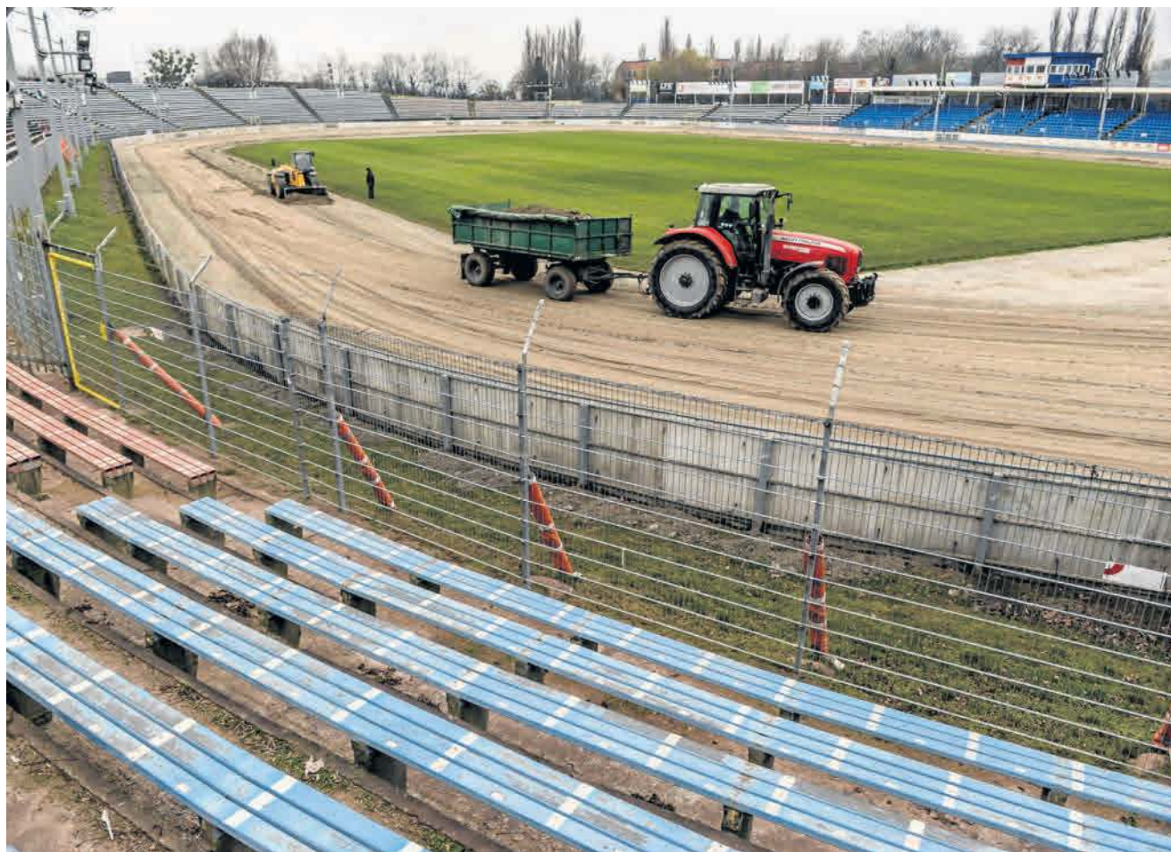
W grudniu ubiegłego roku wymieniona została nawierzchnia gdańskiego toru
