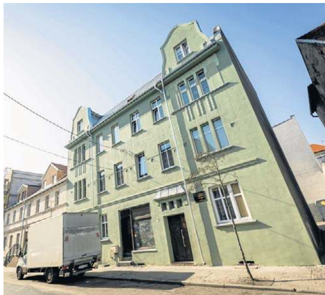
Budynek przy Jasnej 23 został odświeżony - na zielono
