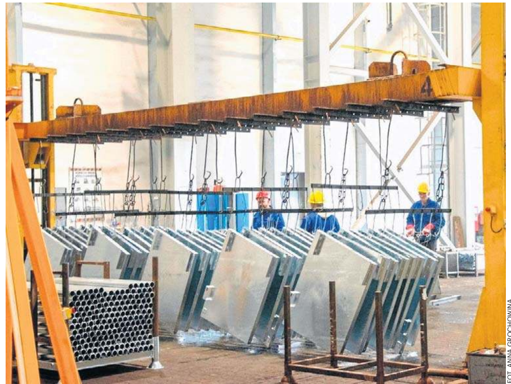
Usługi cynkownicze i produkcja zakładu konstrukcji stalowych. To teraz najważniejsze
