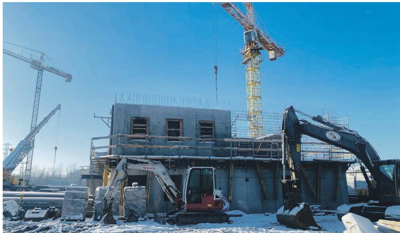
Trwa rozbudowa trzebińskiego zakładu karnego. W ostatnich dniach silne mrozy spowalniają jednak inwestycję
