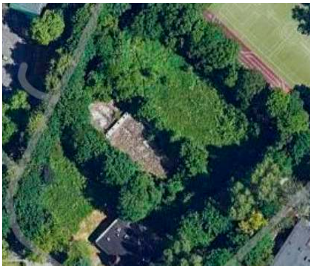
Basen przy ul. Odlewniczej powstał wraz z osiedlem mieszkaniowym w latach 60- tych ubiegłego wieku. Przez lata stanowił letnią atrakcję dla całej dzielnicy. W związku z pogarszającym się stanem technicznym i koniecznością gruntownego remontu, obiekt zamknięto w latach 90- tych. Kilkakrotnie społecznicy domagali się utworzenia tu krytego basenu, na wzór obiektu przy ul. Łąbedziej. Do pewnego czasu nie były jednak jednoznacznie uregulowane sprawy własnościowe gruntów, poza tym miasto, cały czas, zaślaniało się brakiem pieniędzy
