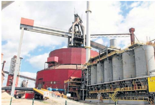
Prace prowadzone będą w pobliżu silosów do magazynowania pyłu i wapna
