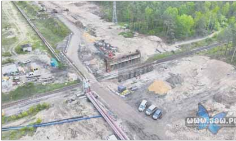
Jaworznicki Obszar Gospodarczy – budowa nowego układu drogowego
