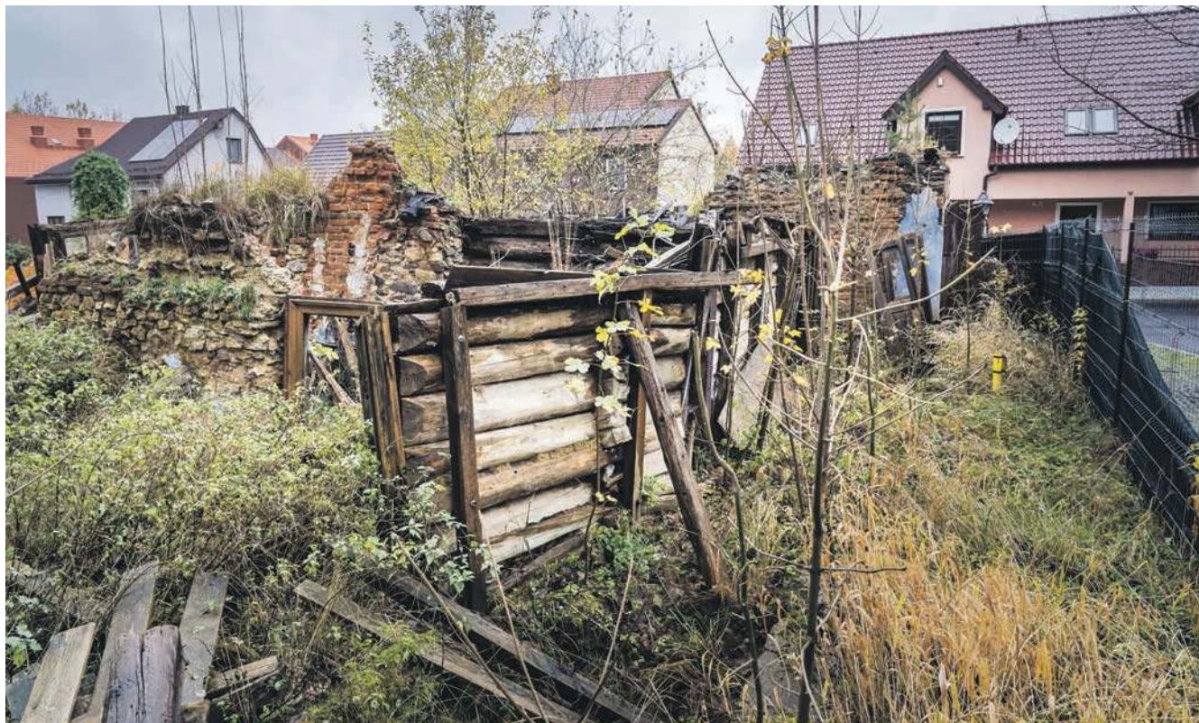
Pozostawione na pastwę czasu pozostałości domu z 1791 roku
