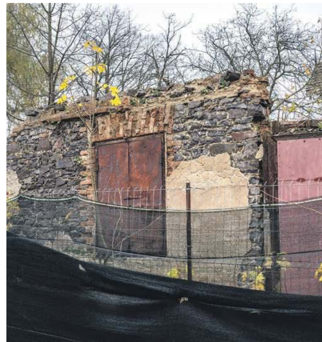
Fragment murowanej, dobudowanej w 1867 roku części budynku
