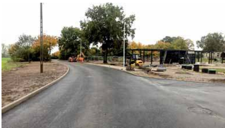
UM informuje, że na ponad miesiąc przed oficjalnym zakończeniem inwestycji większość prac jest już zrobiona
