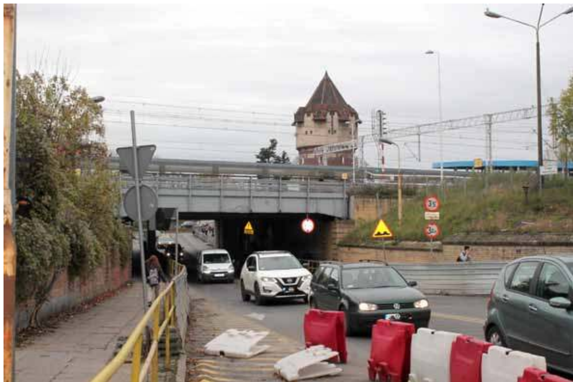
Wiadukt na ulicy Wyszyńskiego zostanie zamknięty w poniedziałek 20 listopada na ok. pół roku
