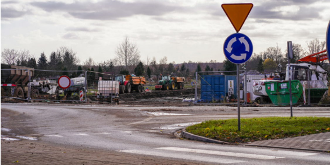
Najkosztowniejszą inwestycją pozostaje budowa ŚOW z wiaduktem.
