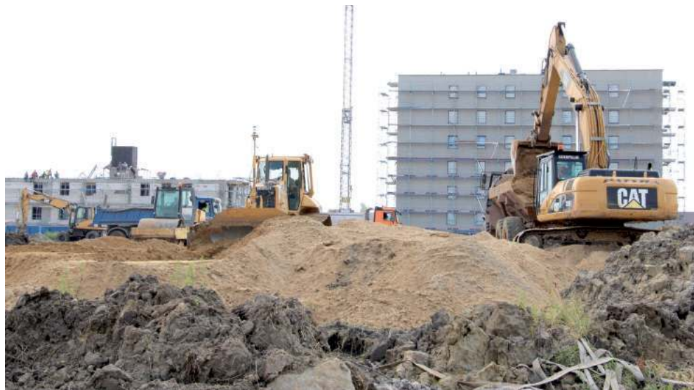
Wykonawca wszedł na plac budowy 2 lipca. Aktualnie trwają prace ziemne
