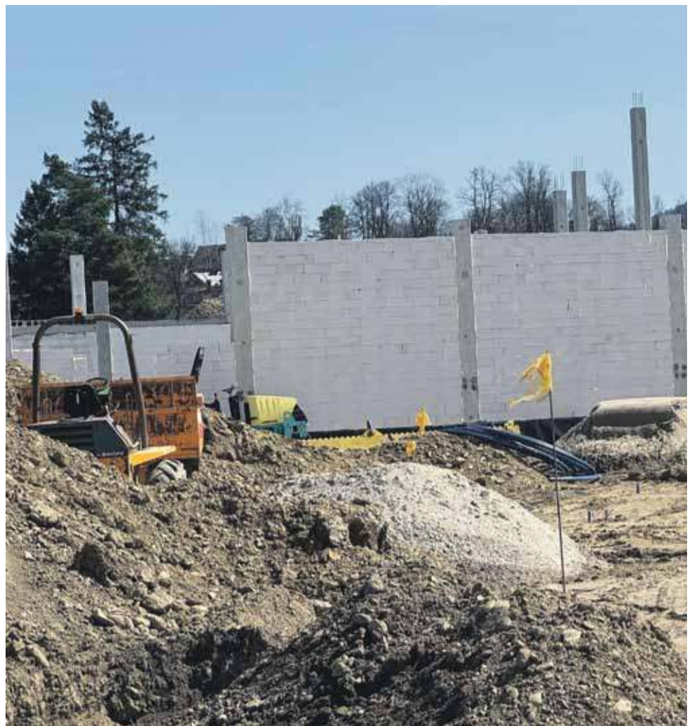
Roboty na placu budowy nowego marketu postępują bardzo szybko.
