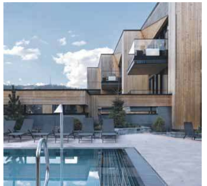
Nowoczesny i znacznie większy obiekt to dzisiejsza Sośnica.
