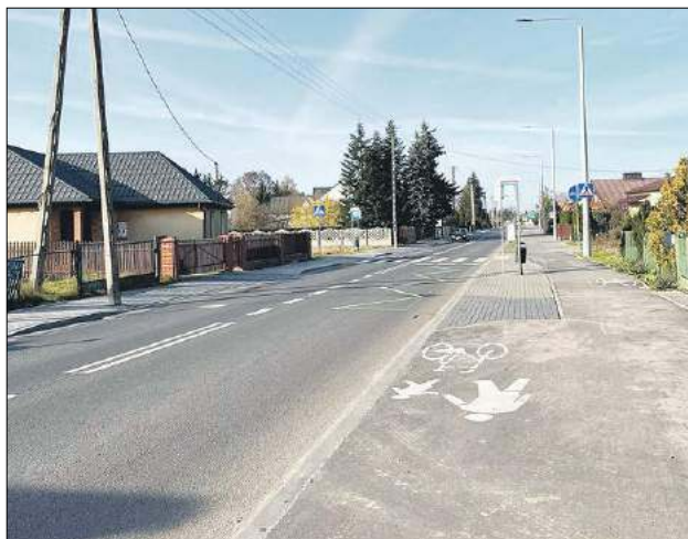
Powstał 1,3 km drogi z dwoma pasami, chodnikiem po stronie południowej i drogą rowerową po północnej, z energooszczędnym oświetleniem ledowym, zatokami autobusowymi i odwodnieniem w formule odsączenia
