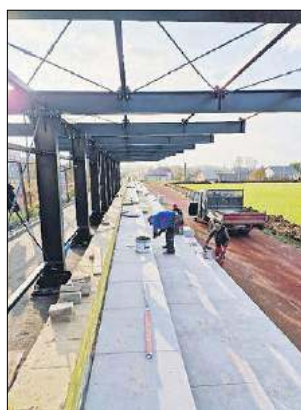
Na stadionie widać już pierwsze zmiany. Pojawiła się konstrukcja zadaszenia trybun, trwa instalacja nawodnienia murawy, remontowane są trybuny
