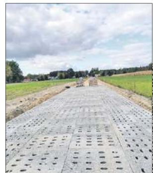
Realizowana jest budowa dwóch dróg w Nowosiółkach, w tym drogi przejętej od powiatu przez gminę na długości 3,7 km
