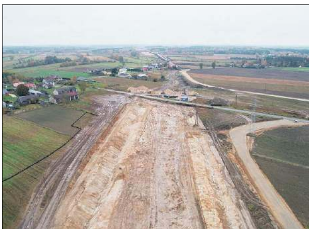
Trwa budowa autostrady A2 na odcinku Swory – węzeł Białą Podlaska (Cicibór)
