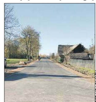
W Korczówce w gminie Łomazy kończy się budowa drogi gminnej. Powstał 241-metrowy odcinek z kościoła w kierunku cmentarza parafialnego
