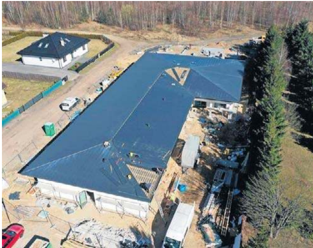
Bryła budynku już została wybudowana i zadaszona
