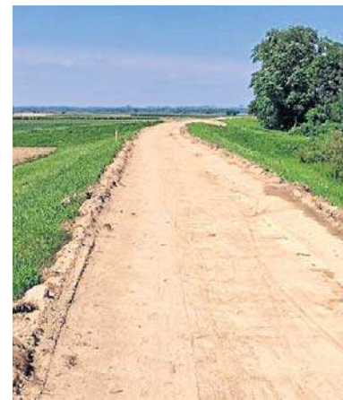
Nowy odcinek powstaje na koronie wału wzdłuż Dunajca
