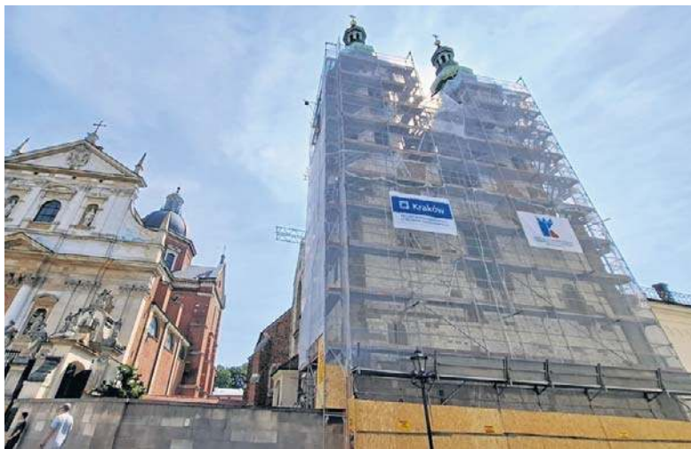
Remont elewacji kościoła św. Andrzeja ma trwać trzy lata
