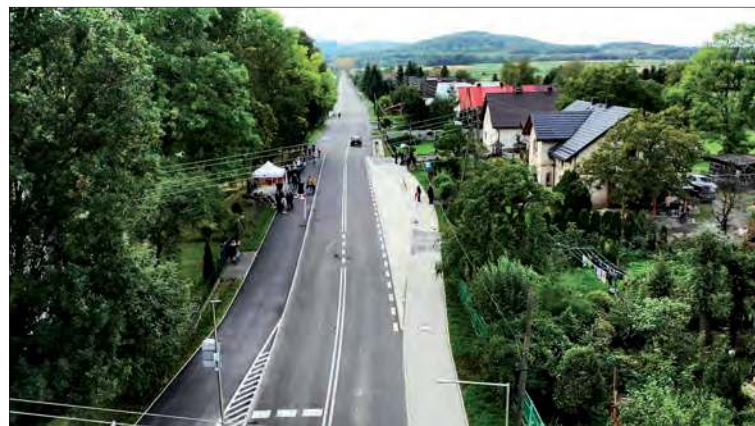
Ukończona niedawno przebudowa drogi w Moszczance
