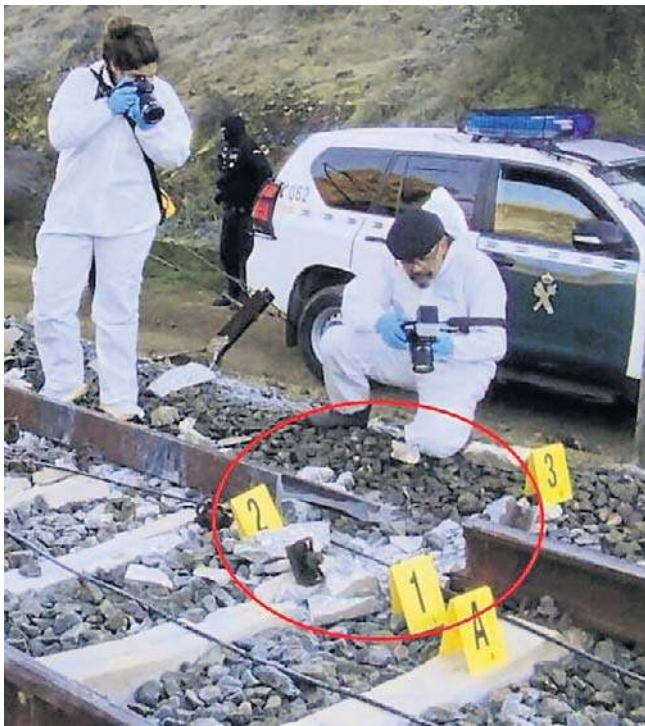
Śledztwo prowadzone przez Komisję ds. Badania Wypadków Kolejowych i policję musi ustalić, czy przerwanie odcinka torów to przyczyna katastrofy, czy też jej skutek
