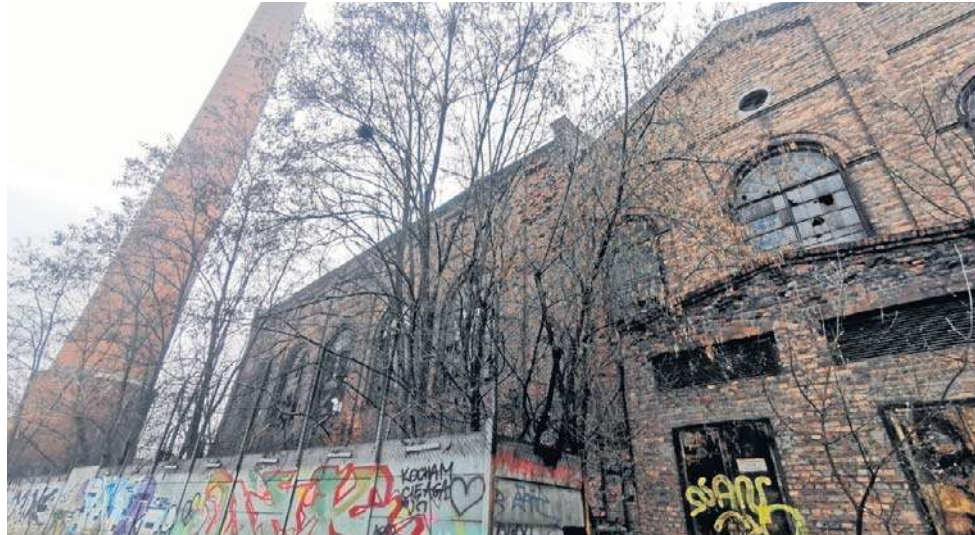
Pokaźny kompleks po fabryce Elanex niszczy od lat. To miejsce z ogromnym potencjałem, w dodatku w doskonałej lokalizacji, bo w samym centrum miasta
