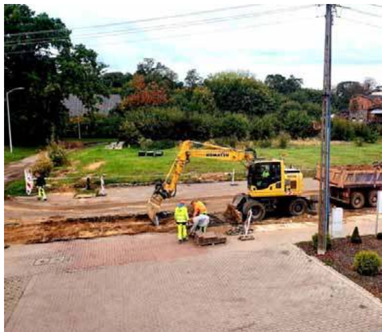
W Starej Dąbrowie trwają prace ziemne, polegające na wykonaniu odwodnienia drogi
