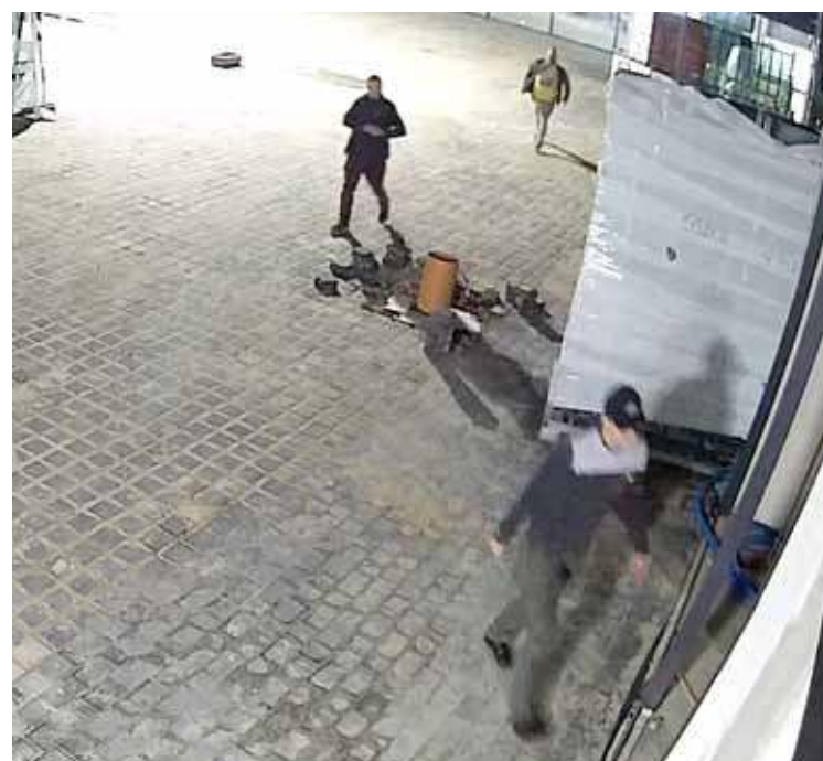
Najwyraźniej włamywacze byli trochę zaskoczeni, że na terenie budowy nie pozostawiono nic co można zabrać
