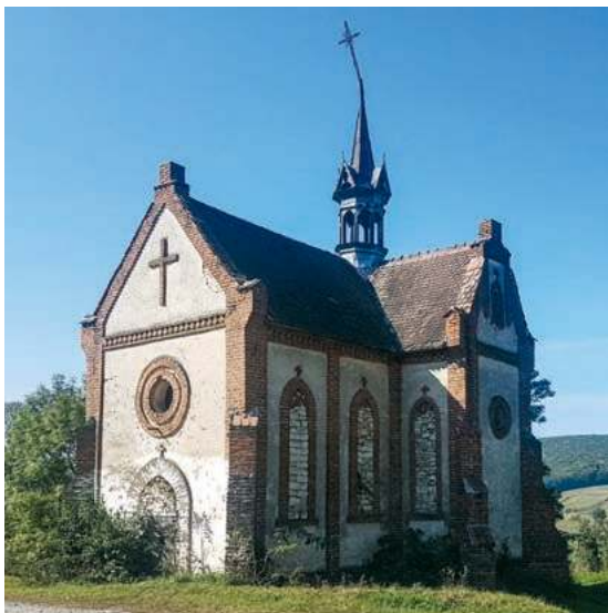
Opuszczony XIX-wieczny kościół we wsi Nadriczne (do 1946 r. wioska nosiła nazwę Dryszczów), wrzesień 2018 r.
