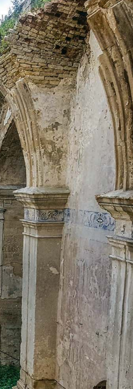
Ruiny gotycko-renesansowego kościoła Trójcy Świętej w Podhajcach, czerwiec 2019 r.
