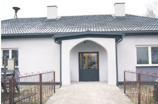
Wyremontowana świetlica w Ignatowie-Kolonii
