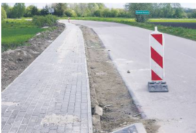
Modernizacja drogi w Kamieniu-Kolonii
