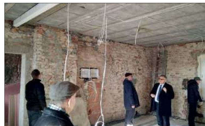
W 2017 r. władze gminy podjęły decyzję, że budynek po dawnym przedszkolu gruntownie wyremontują na cele usługowo-biurowe. Tak też się stało, na co budżetu przeznaczono nieco ponad 1 mln zł.
