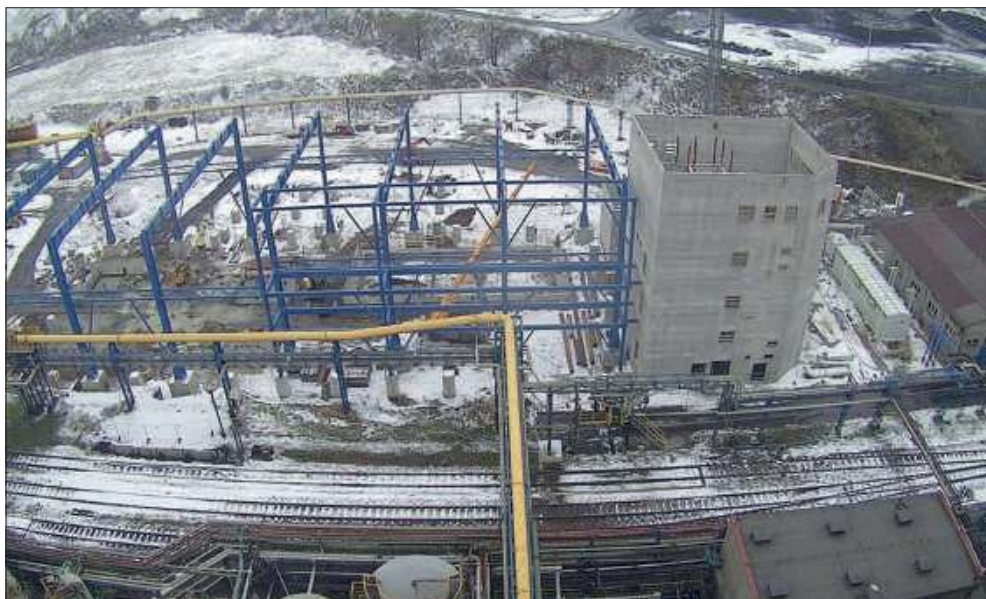
Funkcjonariusze CBA pojawili się w JSW Koks. Jak udało nam się ustalić, chodzi o kontrolę dotyczącą Elektrociepłowni Radlin, a konkretnie budowę bloku energetycznego. (fot. JSW Koks)
