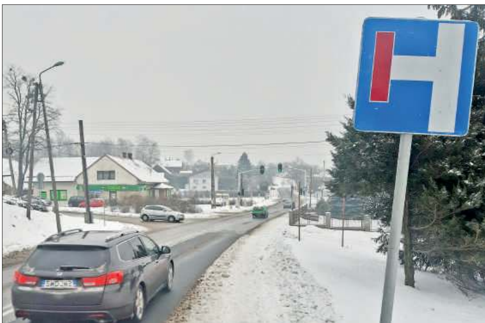
Znak D-4b informuje o wjeździe na drogę bez przejazdu. Tymczasem ul. Sportową można już od kilku miesięcy przejechać na drogę wojewódzką nr 933. Nieoficjalnie, bo oficjalnie DW 933 to nadal plac budowy, po którym można poruszać się tylko dojeżdżając do posesji.
