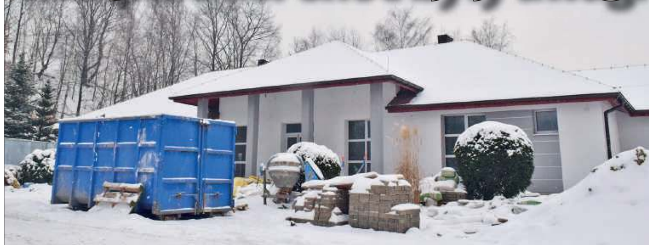
Remont Krytej Pływalni w Połomi trwa. Obiekt będzie jak nowy. Cały.
