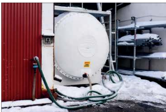
Zbiornik z solanką. Wlewa się ją do zbiornika znajdującego się na pługopiaskarce. Zmieszana z solą drogową trafia na drogi.
