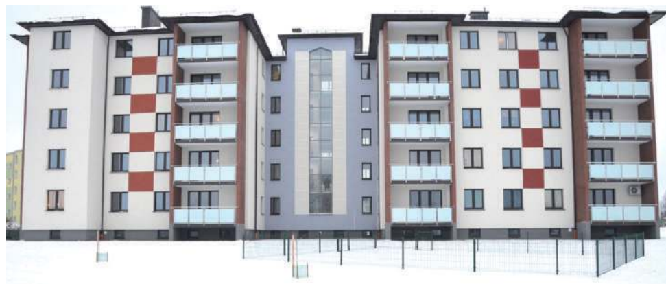
Nowy budynek mieszkalny przy ul. Króla Kazimierza Jagiellończyka 6 C jest w tej chwili zasiedlany. Chociaż trwają ostatnie drobne prace, niektórzy właściciele śpieszą się z wejściem do mieszkania, bo chcą spędzić tutaj święta
