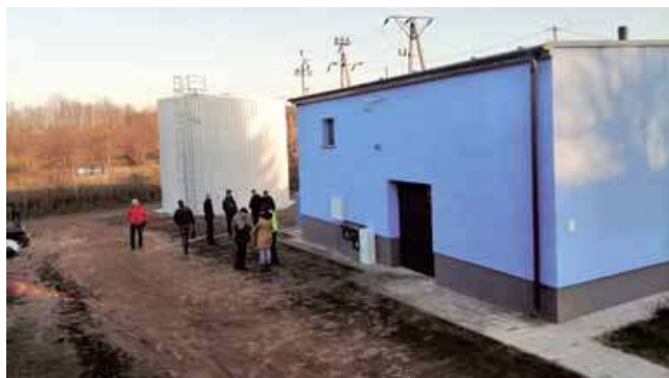
Hydrofornia po remoncie
